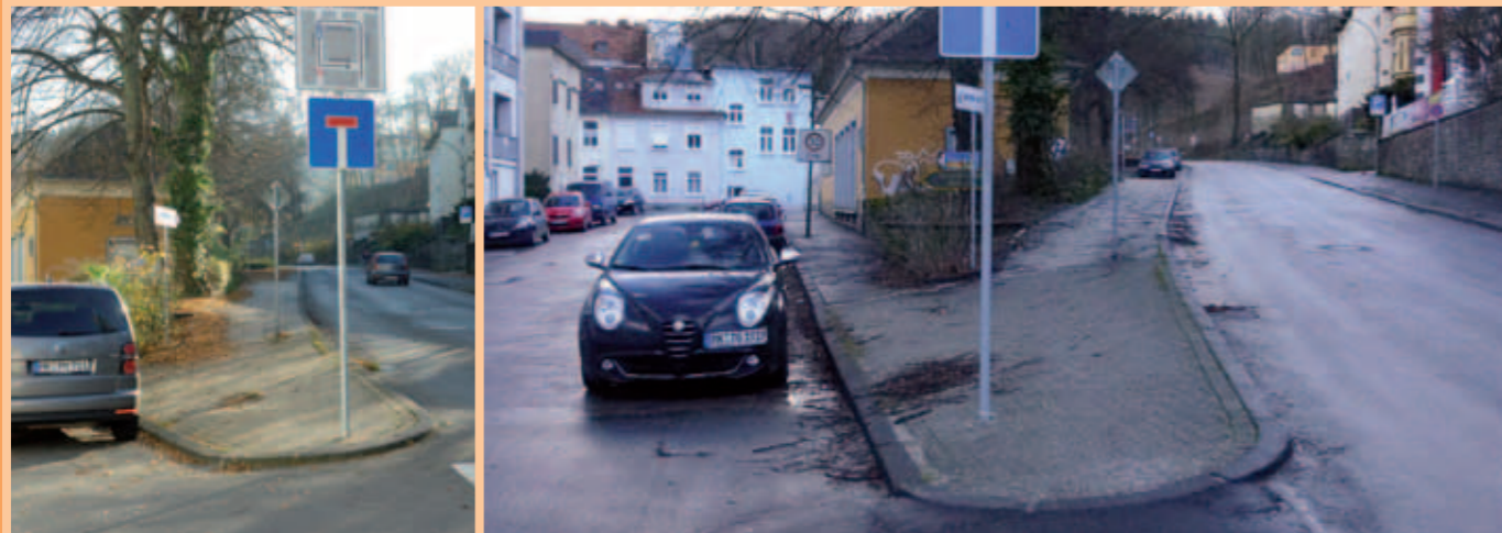
Der Bürgersteig vor (links) und nach den Änderungen (rechts): Das Schild wurde umgesetzt und der Gehsteig abgeflacht, um Eltern mit Kinderwagen und Rollstuhlfahrern das Überqueren der Straße zu erleichtern.
